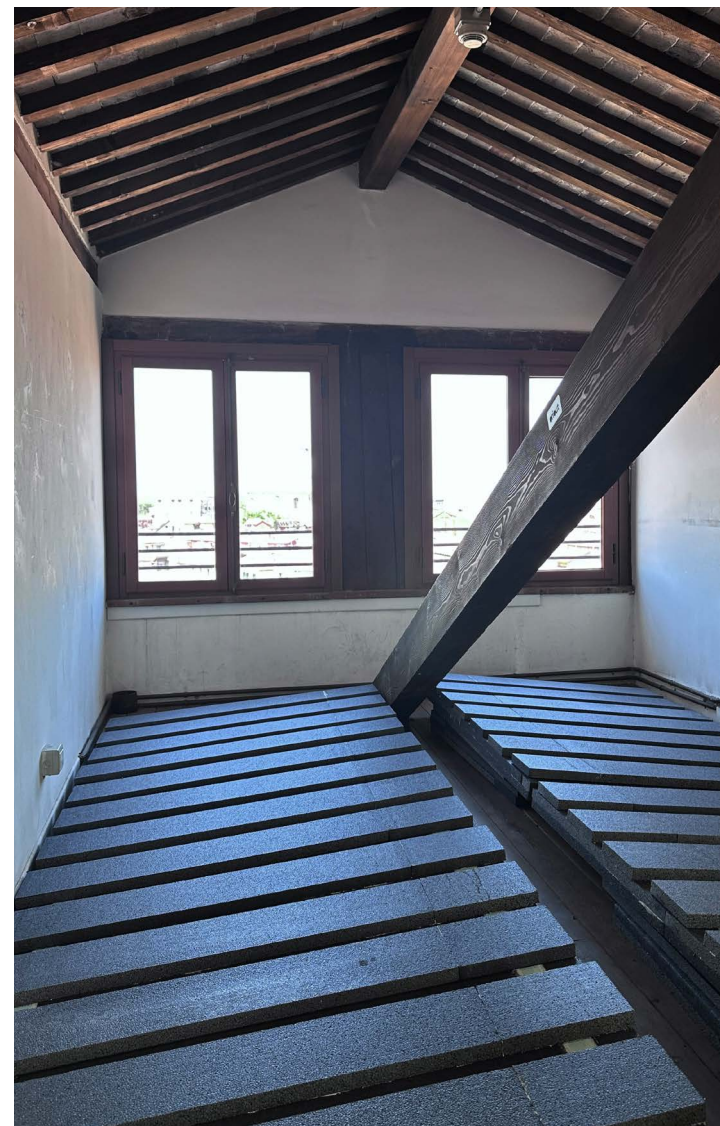
View Cappotto termico tetto lucernario atelier 7 Palazzo Carminati Venezia, 2024,
