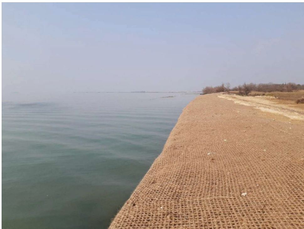
Figura 12. Marginamento di nuova costituzione, non pedonabile, lungo il lato sud dell'isola, fronte laguna.
