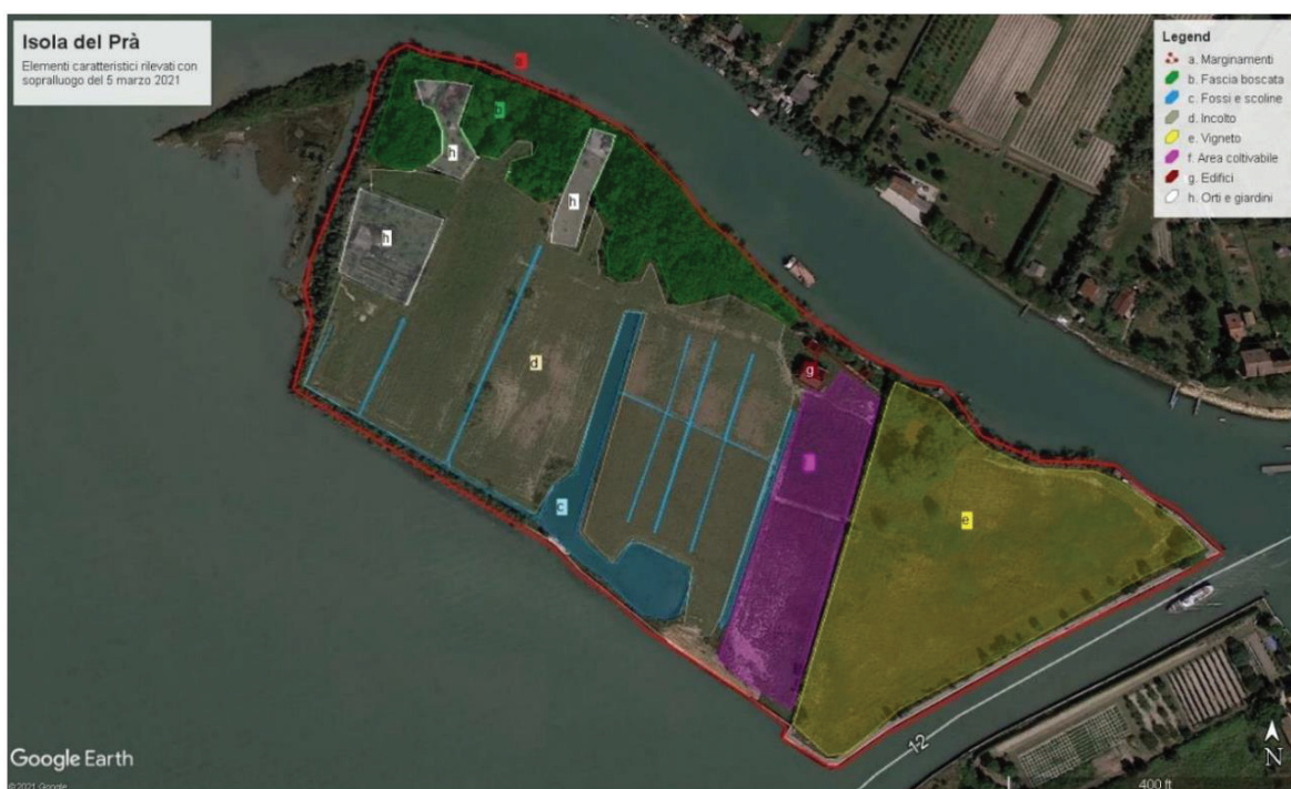
Figura 1 - Isola del Prà – Stato attuale degli elementi caratterizzanti
