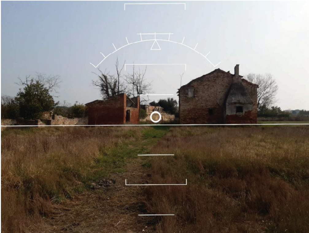
Figura 25. Strutture edilizie esistenti.
