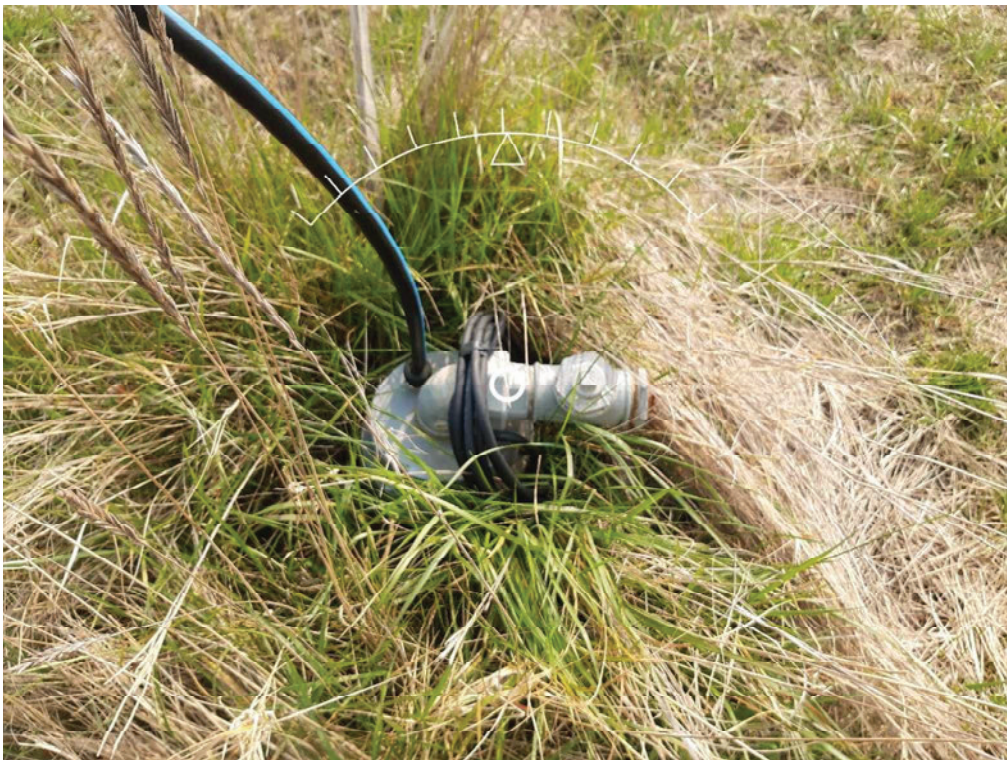
Figura 26. Pozzo per irrigazione di soccorso.
