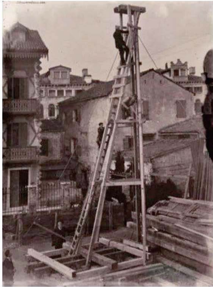
foto - demolizione del vecchio fabbricato lungo calle dei Guardiani
