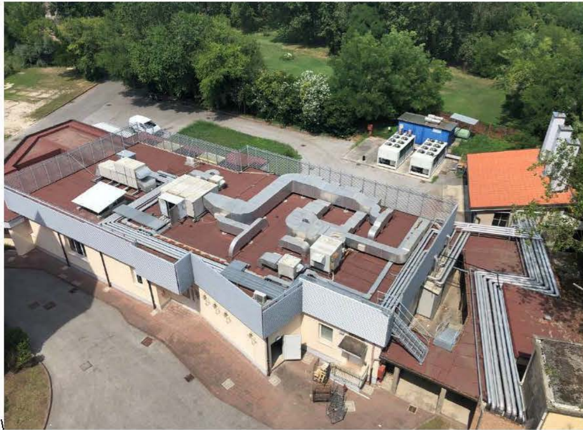
Vista 5 – Centro cottura da demolire
