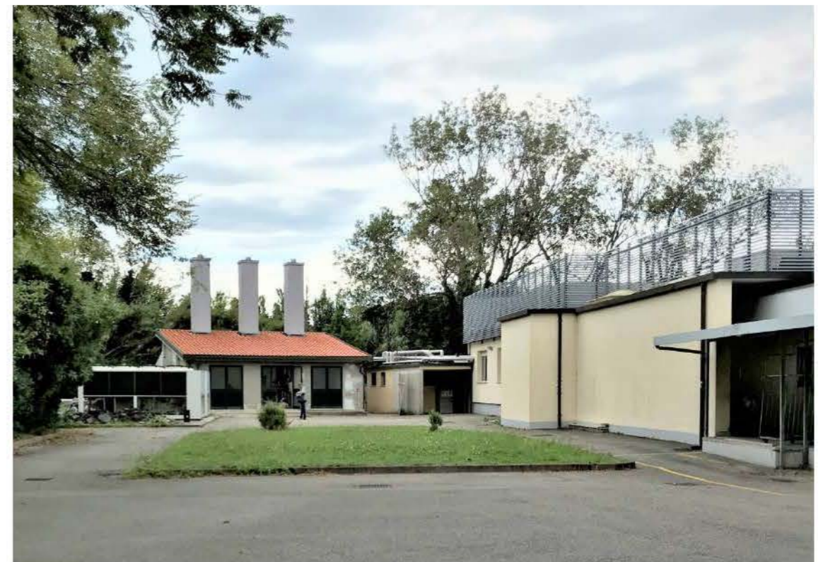
Vista 8 – locali tecnici - centrale termica
