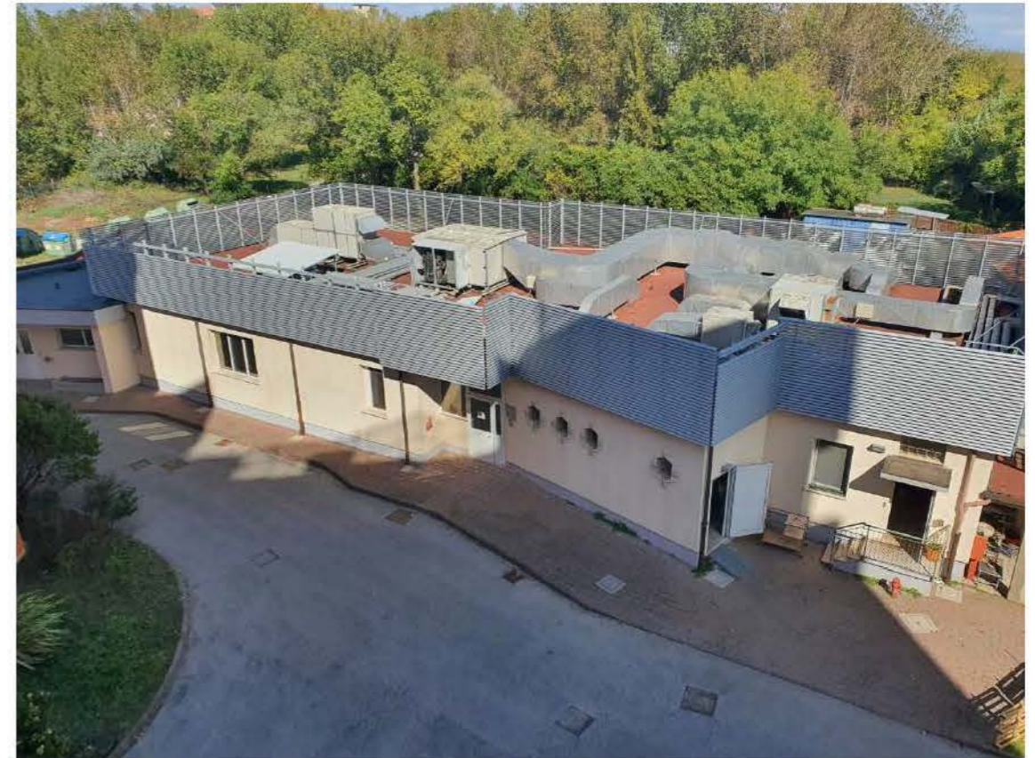
Vista 7 – Centro cottura da demolire
