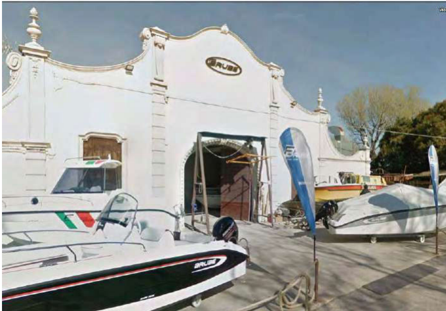
Figura 14 Facciata dell'edificio del cantiere nautico.
