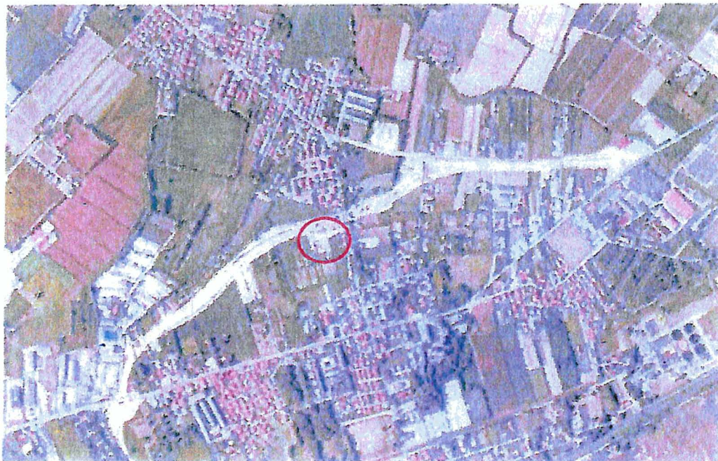
Figura 1: Individuazione dell'area utilizzata come cantiere base in Via Gobbi
