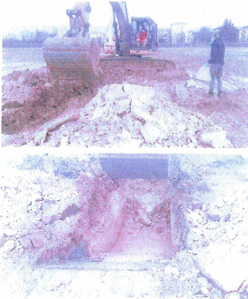
Figura 5: Foto di alcune delle trincee esplorative eseguite per la formazione dei campioni
