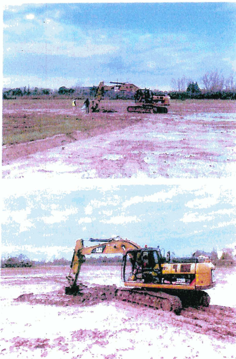
Figura 4: Attività di esecuzione delle trincee esplorative per la formazione dei campioni
