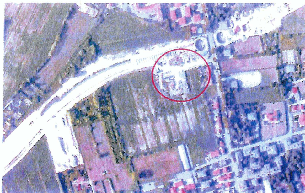
Figura 2: Individuazione dell'area utilizzata come cantiere base
