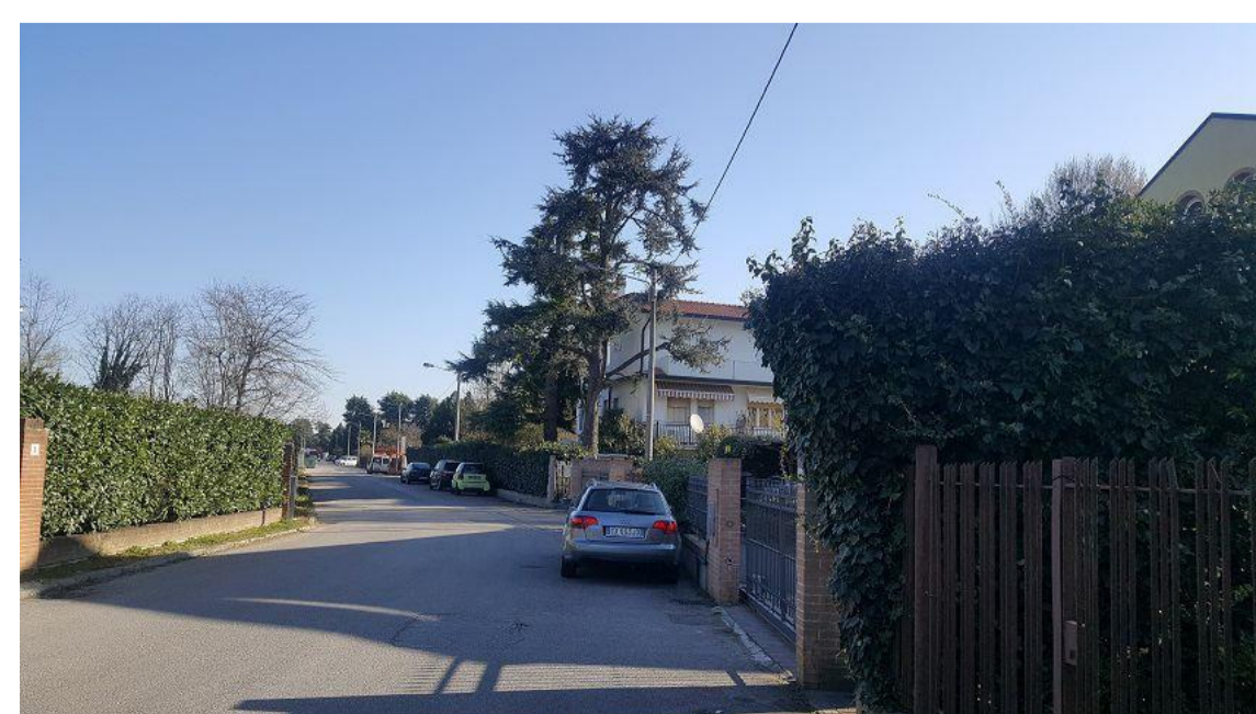
FOTO N°27 - IMBOCCO DI VIA BELLOTTO DA VIA CASTELLANA
