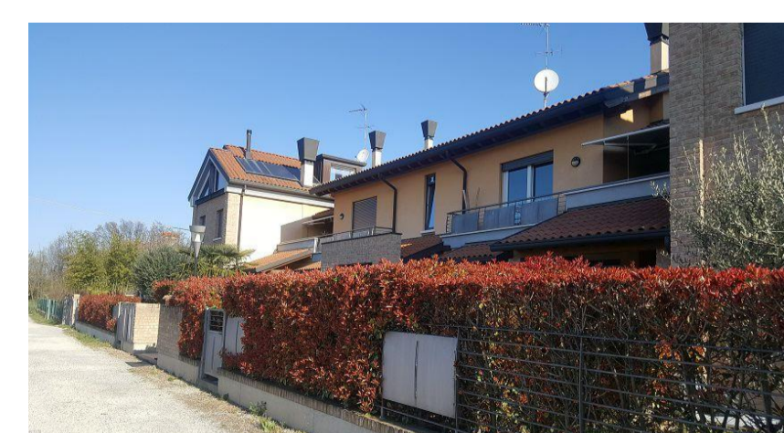
FOTO N°22 RAMO DI VIA BELLOTTO
