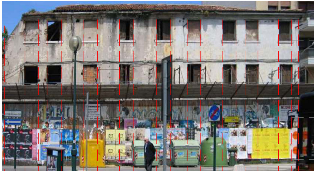
Stato attuale - foto del 2011 (raddrizzata)
