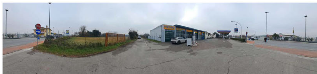
Foto n. 2: Visione d'insieme dell'accesso da Via Orlanda
