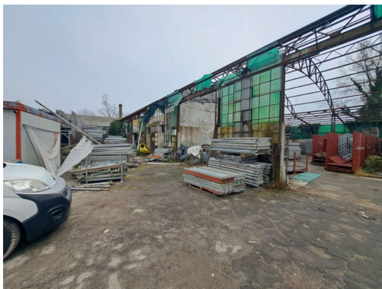
Foto n. 9: vista del fabbricato (porzione del sub.7) da Nord-Ovest
