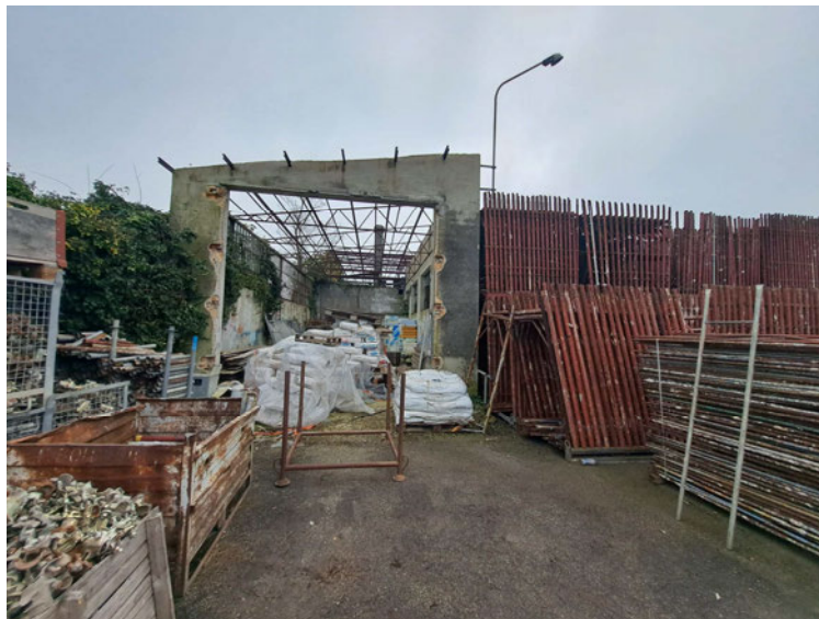
Foto n. 8: vista del fabbricato (porzione del sub.8) dall'angolo Nord-Est
