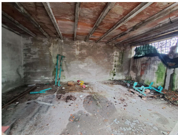
Foto n. 11: vista dall'interno del fabbricato (porzione del sub.7)
