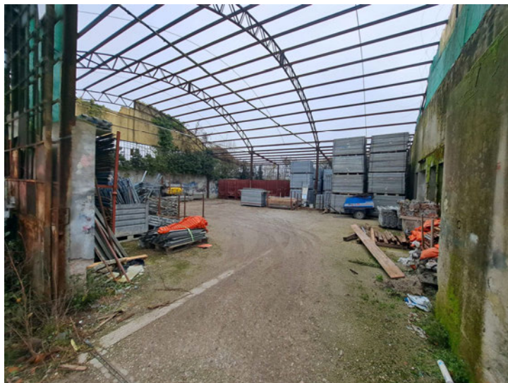
Foto n. 12: vista dall'interno del fabbricato (porzione del sub.8)
