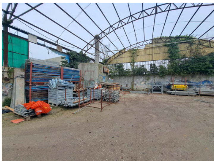
Foto n. 14: vista dall'interno del fabbricato (porzione del sub.8)
