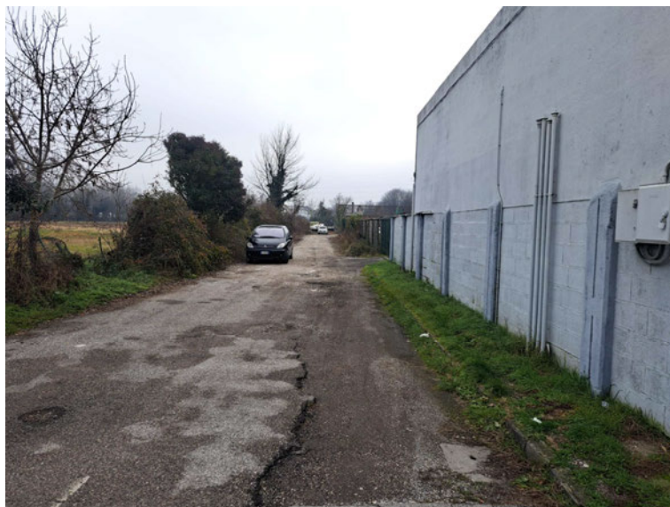
Foto n. 4: Vista dell'accesso da Via Orlanda.
