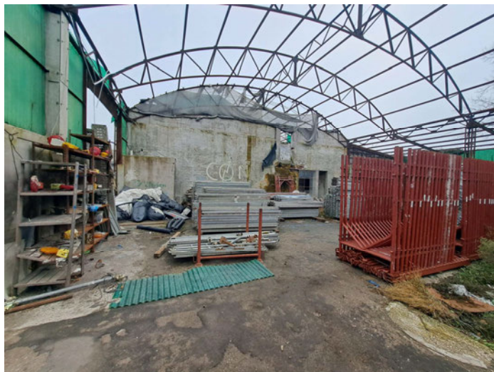
Foto n. 10: vista dall'interno del fabbricato (porzione del sub.7)
