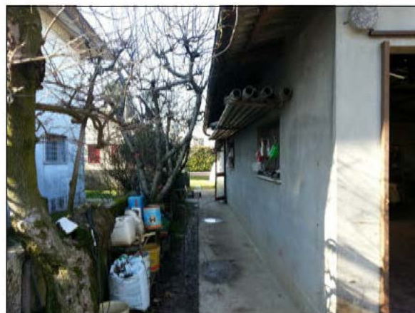
FOTO 4: VEDUTA PROSPETTO SUD
