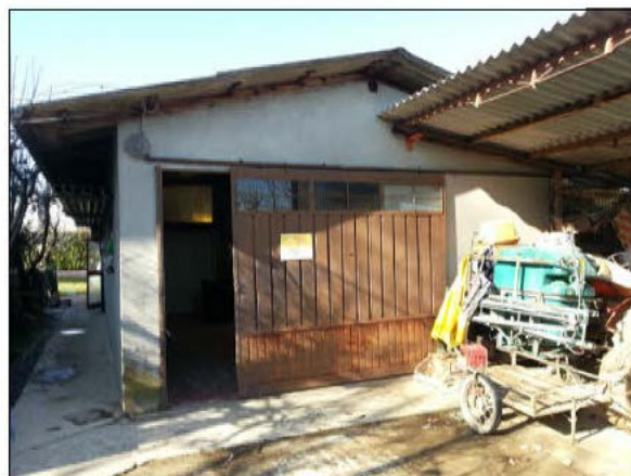
FOTO 1: PROSPETTO EST - LABORATORIO ARTIGIANALE
