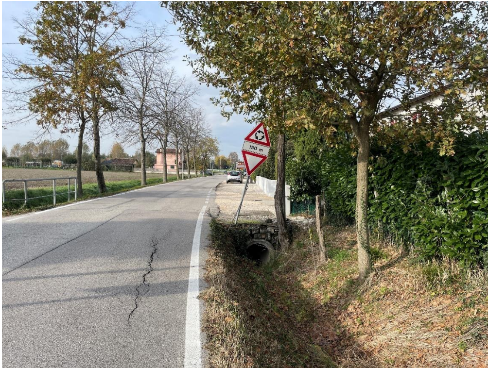
Foto 6 - Tombinamento esistente su via Morosini
