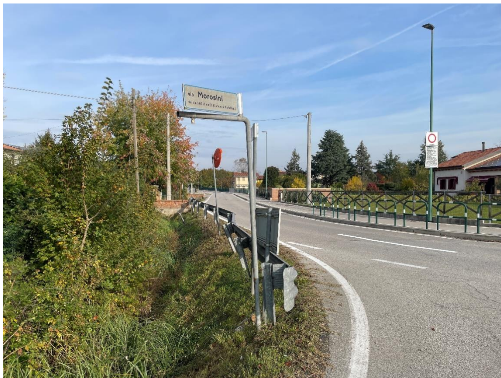
Foto 5 - Incrocio via Ponte Nuovo - via Morosini
