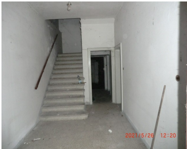
Foto n. 3 - Ingresso e rampa verso il primo piano
