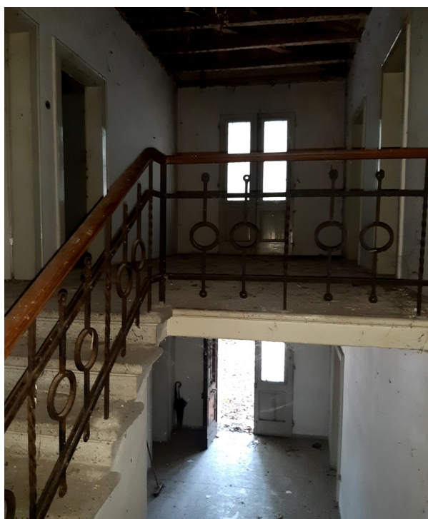
Foto n. 8 – Vano scale: vista ingresso piano terra e disimpegno piano primo
